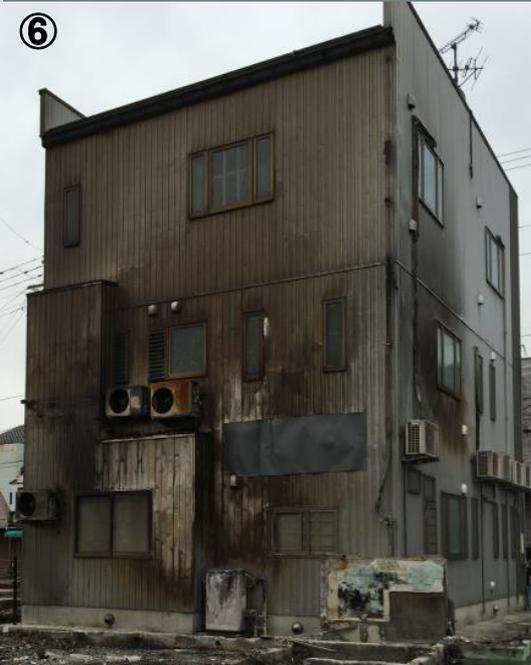
火元建物の5軒北側(風下側)で隣棟が燃えているが、延焼を免れた。鉄骨造かつ石膏ボード外張り、窓は外側に網入りガラスが設けられた複層ガラス
