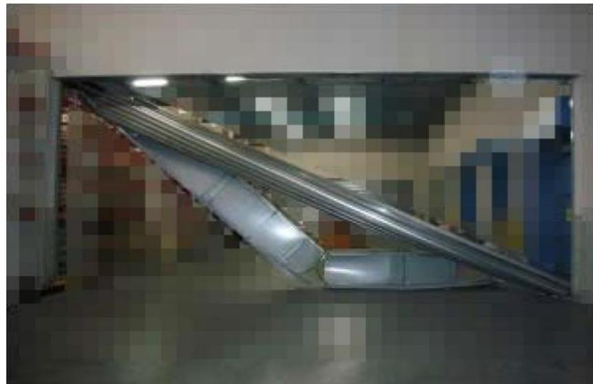
防火シャッターが揺れで損傷した例
